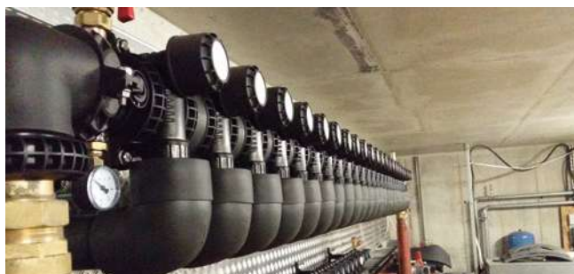
Фотография показывает 27-контурный коллектор ProCalida GT3 в системе грунтового теплообменника теплового насоса. Система находится в торговом центре Huta в местечке Węgierska Góra (Южная Польша).
